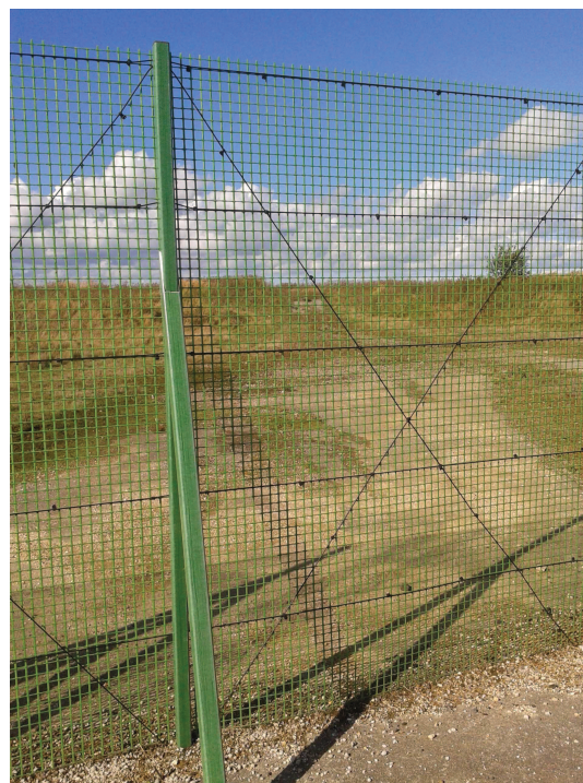
Source : DSAC. Clôture amagnétique, autre vue.
