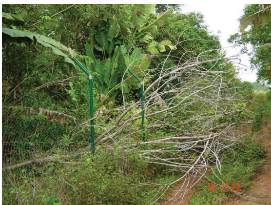
Source : DSAC – Clôture endommagée à la suite d'une chute d'arbre
