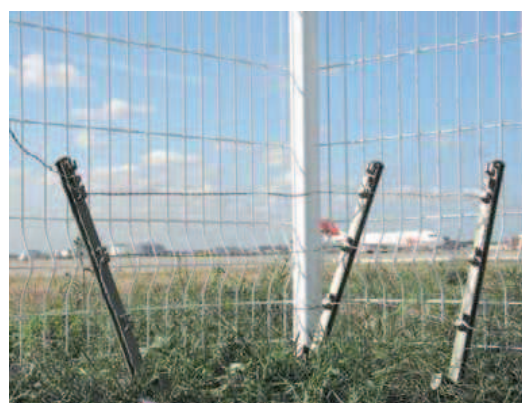
Clôture électrique permanente Source : STAC
